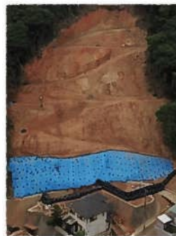
応急復旧状況
