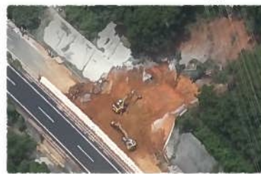
【完成 4 車線区間】九州自動車道
