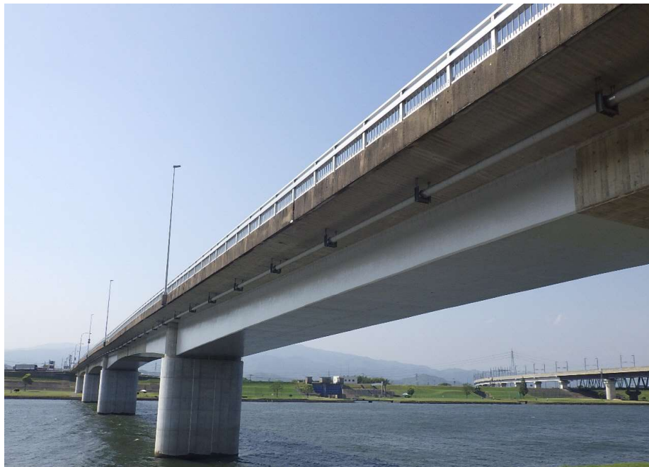
【筑後市】 市道一条田中線 踏切改良事業の事例
