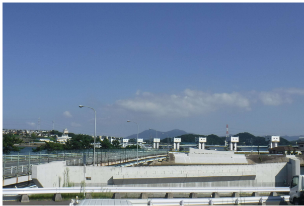
主要地方道 直方芦屋線 西祇園橋 (芦屋町)
