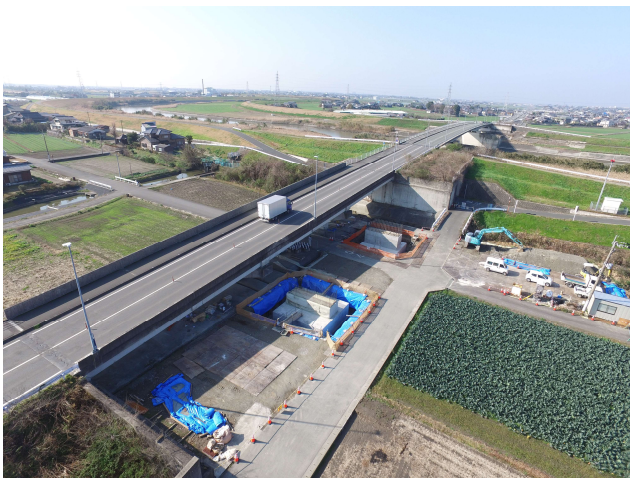
一般国道 443 号 三橋瀬高バイパス（4 車線化） (柳川市～みやま市)
