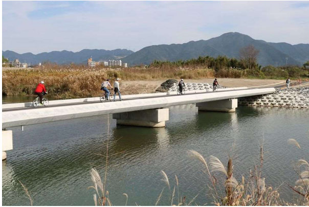
一般県道 直方北九州自転車道線 直方市・鞍手町工区 (直方市)
