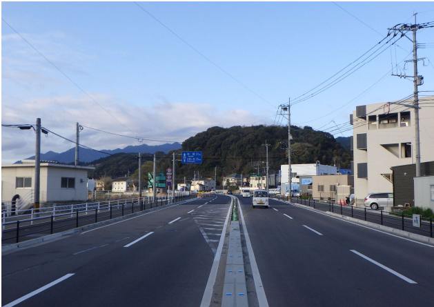
一般国道 385 号 那珂川拡幅・那珂川拡幅Ⅱ期 (那珂川市)
