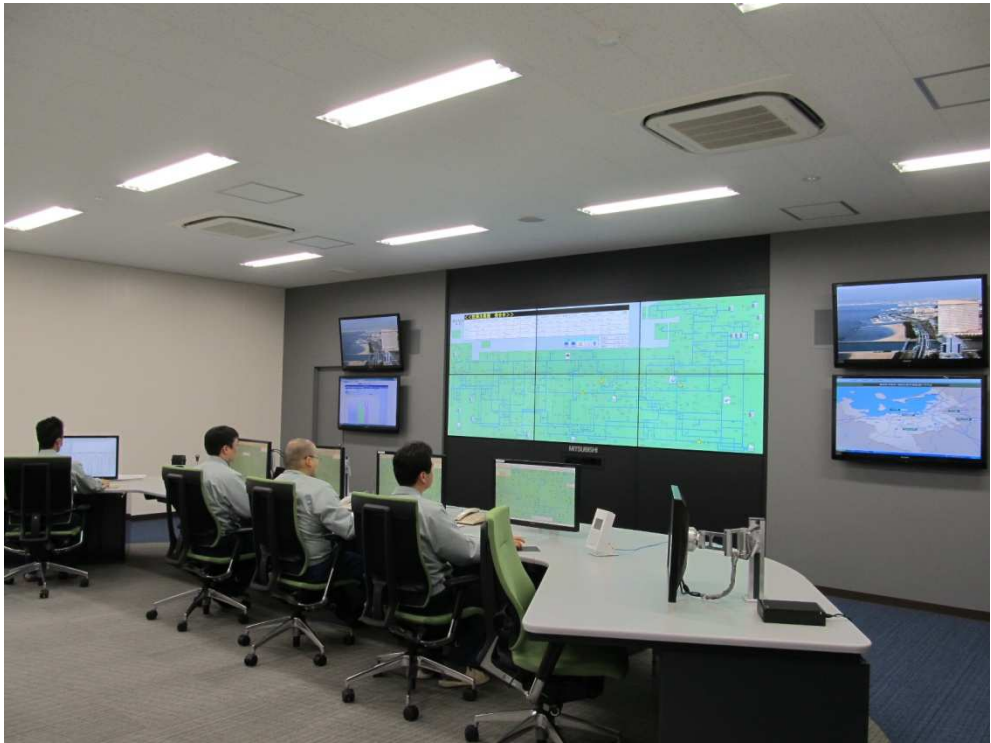
【福岡市水道局 水管理センター】
