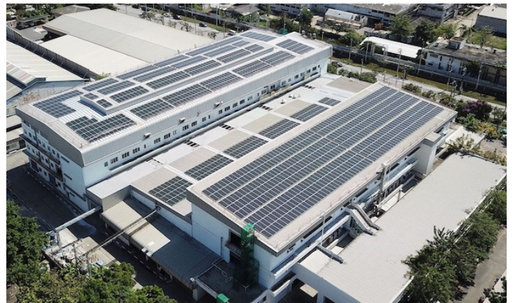
▲ Ví dụ lắp đặt nơi sản xuất điện năng lượng mặt trời mái nhà
