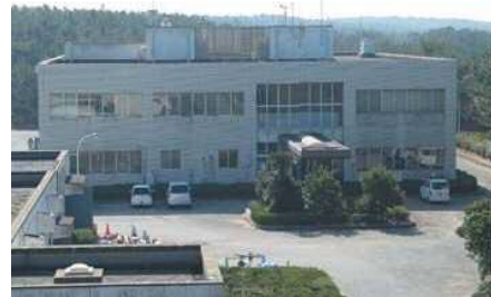
芦屋町浄化センター(芦屋町)
