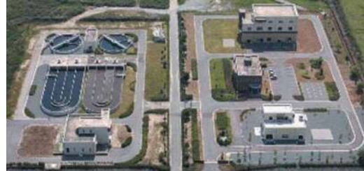
柳川浄化センター（柳川市）
