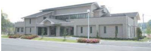
福間浄化センター（福津市）
