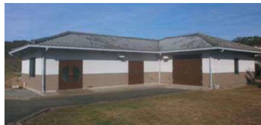
上長田浄化センター（みやま市）
