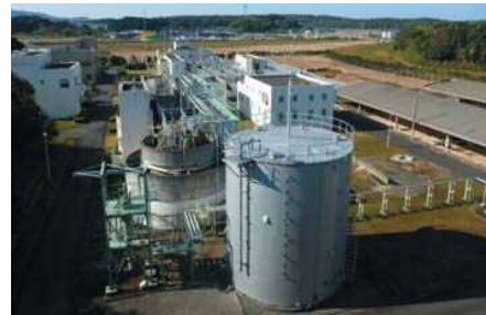
岡垣町浄化センター(岡垣町)
