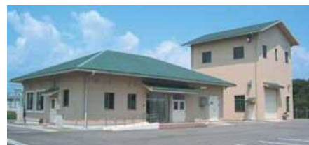
築城浄化センター(築上町)
