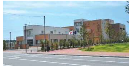
新宮中央浄化センター(新宮町)
