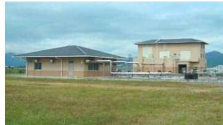
三輪中央浄化センター(筑前町)
