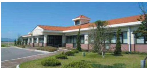
行橋浄化センター（行橋市）
