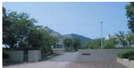
前原下水管理センター（糸島市）
