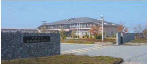
南部浄化センター（大牟田市）
