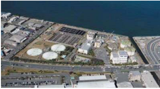
新町浄化センター（北九州市）
