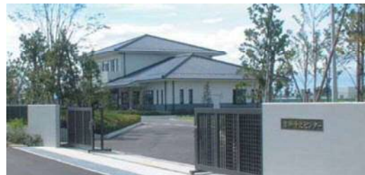
吉井浄化センター（うきは市）
