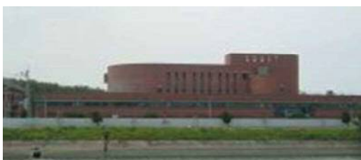
古賀水再生センター（古賀市）
