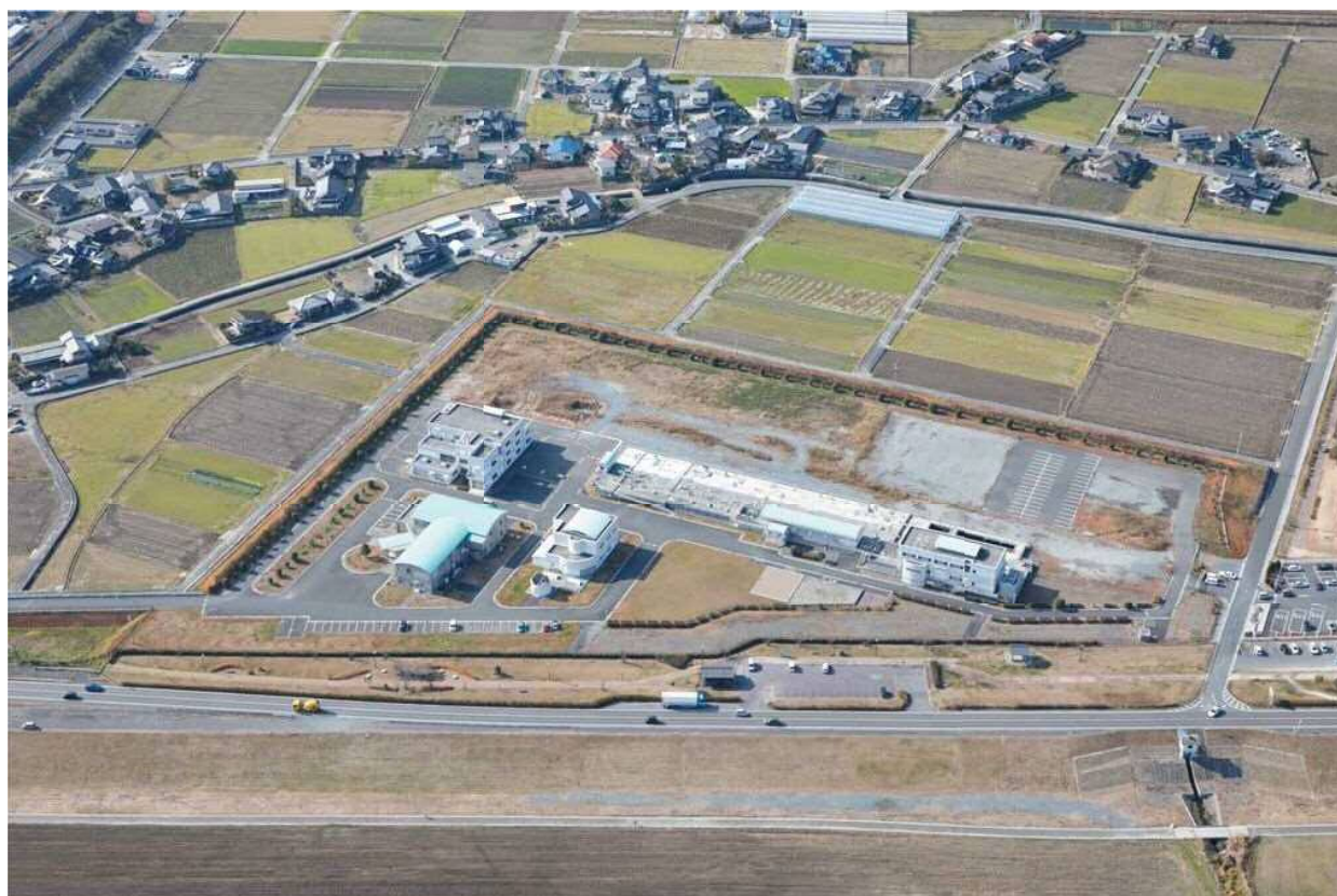
遠賀川中流浄化センター
