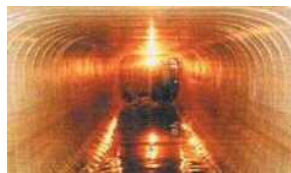
管内面を更生材により被覆した複合管
