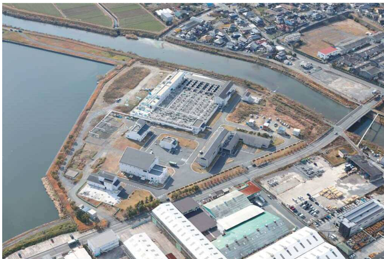
遠賀川下流浄化センター
