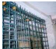
コンクリート壁の新設
