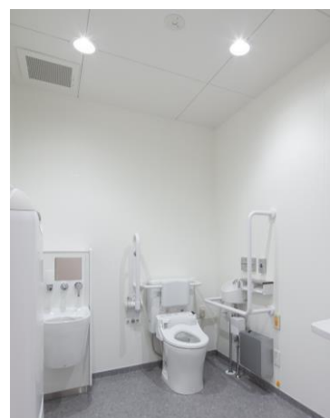
多目的トイレ(人感センサー,節水型機器)
