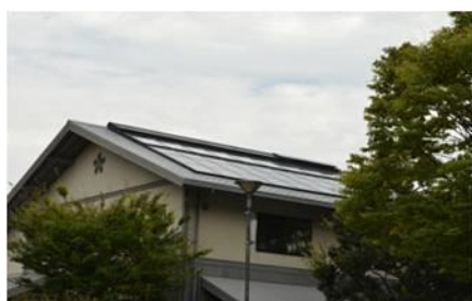
太陽光パネル
