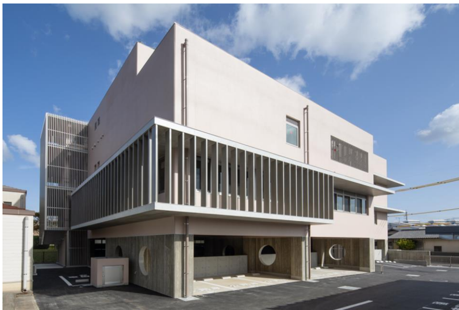
外観(南西面の庇・ルーバー)
