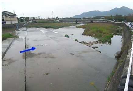
茶屋原堰（固定堰）平成23年11月の状況
