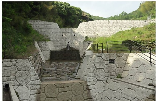
砂防堰堤（山中川 八女市黒木町）
