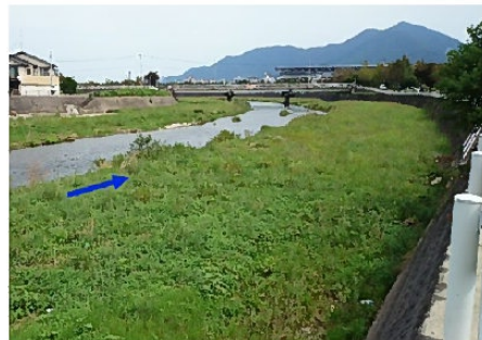
茶屋原堰（集水埋渠）平成27年9月の状況
