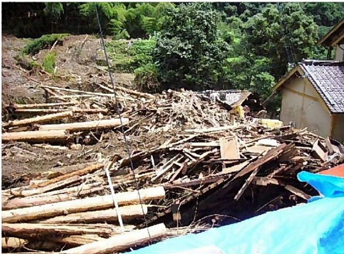
土石流の被害状況
