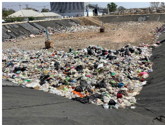
タイ・シーキウ市処分場の埋立状況
