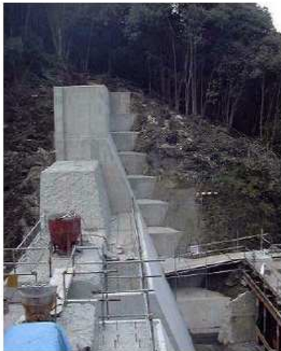
図 4-1-74(1) 間詰コンクリート(岩盤部)
