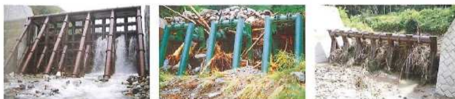
土石流・流木捕捉事例
