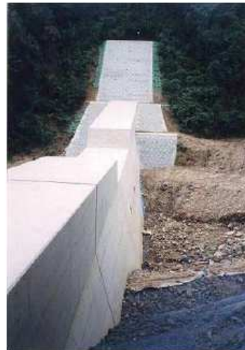
図 4-1-74(2) 間詰め工(土砂部)
