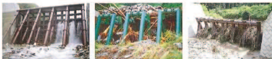
土石流・流木捕捉事例
