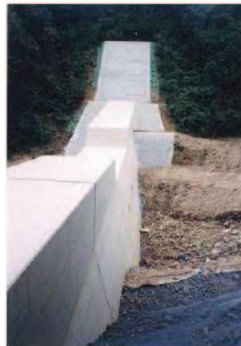
図 4-1-74(2) 間詰め工(土砂部)
