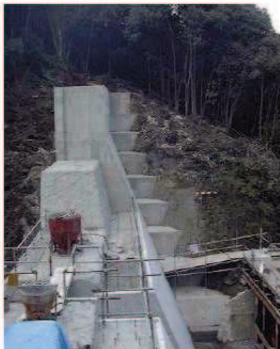
図 4-1-74(1) 間詰コンクリート(岩盤部)
