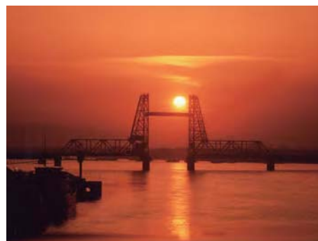
夕陽に映える筑後川昇開橋（大川市）
