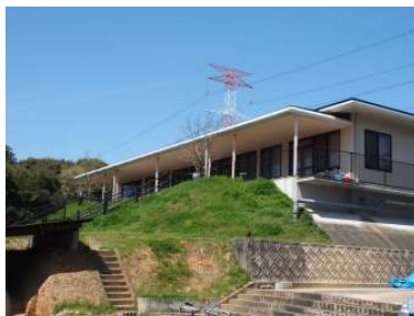
宅地造成で生じた法面への緑化
