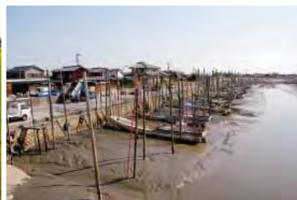
矢部川下流の河川沿いに設けられた漁港
