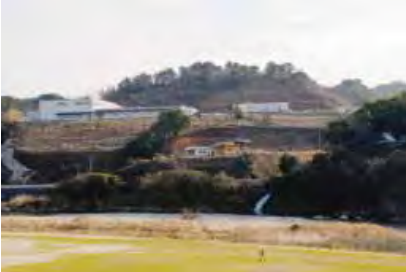
矢部川中流から下流の行政区付近では工場などが立地し、斜面地開発では地形の改変や樹林の伐採などが行われる。
