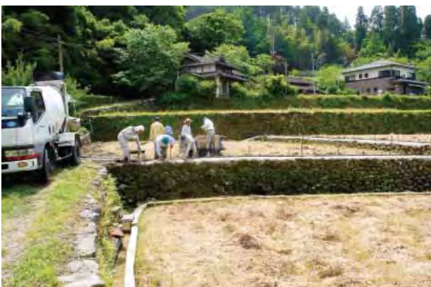
棚田の修復作業（黒木町）
