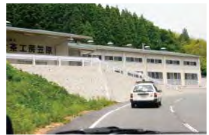
急峻な地形の山間部では、宅地造成や道路等によりコンクリート擁壁が必然的に生じる。緑化等が望まれる。
