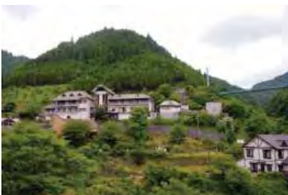
周辺の自然景観と調和して「秘境杣の里溪流公園」の施設群が建つ。山間部では、別荘、宿泊施設など立地が想定される。
