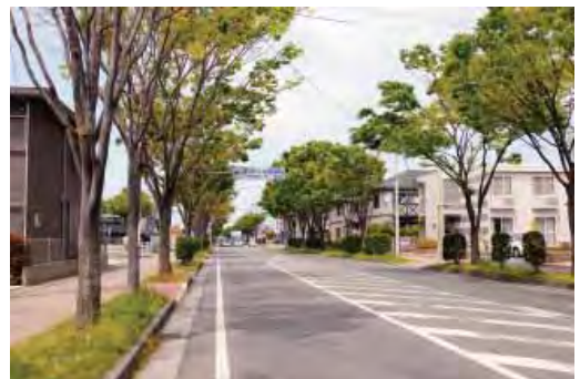
整備された筑後市の道路
