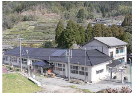
廃校となった小学校を再利用した農林業交流体験施設「えがおの森」（黒木町）
