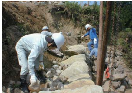
棚田の修復作業（黒木町）
