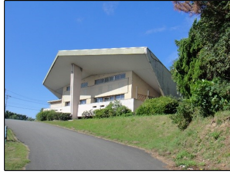
志賀島ビジターセンター(福岡市)
