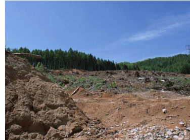
住宅地造成のための森林伐採
