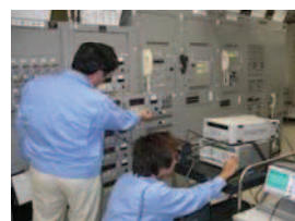
（航空保安施設点検実施状況）
