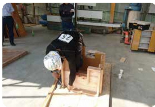
技能実習生の技能検定(型枠施工)
