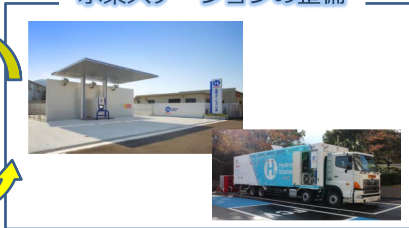
水素ステーションの整備
