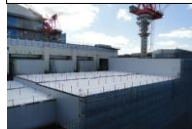
タービン建屋・廃棄物建屋
