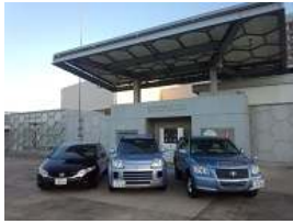
九州大学 水素ステーション 太陽光発電の電気を利用した 水電解方式のステーション
