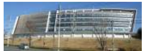
カーボンニュートラル・エネルギー国際研究所 ・次世代燃料電池産学連携研究センター
