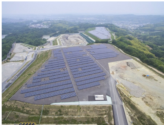
ภาพถ่าย ตัวอย่างการใช้งานพื้นที่หลังปิดบ่อฝังกลบ (โรงไฟฟ้าพลังงานแสงอาทิตย์ : DINS เมก้าชาร์ล)
