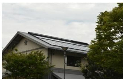
太陽光パネル
