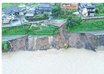
道路復旧状況 八女香春線(八女市)
