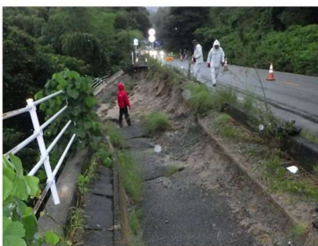
道路復旧状況 南関大牟田北線(大牟田市)
