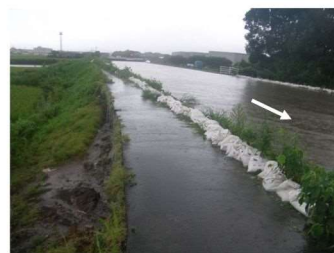
河川復旧状況 花宗川(筑後市)
