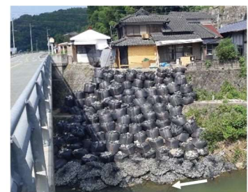
河川復旧状況 諏訪川(大牟田市)
