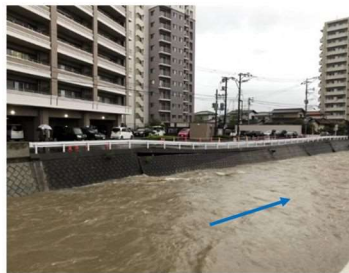
河川復旧状況 山口川(筑紫野市)
