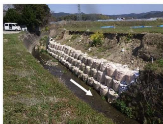
河川復旧状況 こうだらき 上津荒木川(久留米市)
