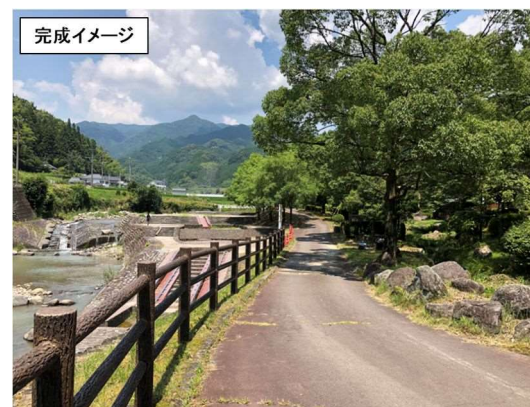
宝珠山川管理用通路の整備
