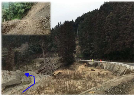
道路啓開状況
