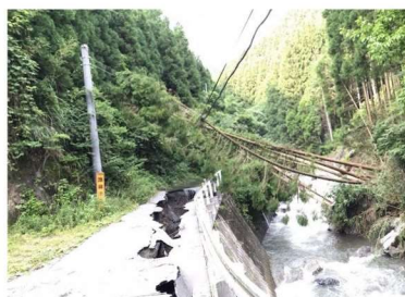
道路復旧状況 うきはしかわち 浮羽石川内線(八女市)
