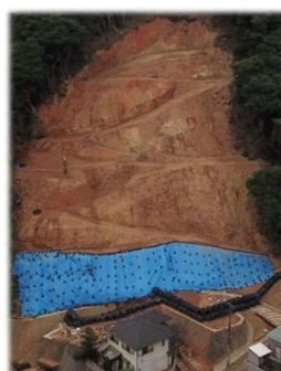
応急復旧状況
