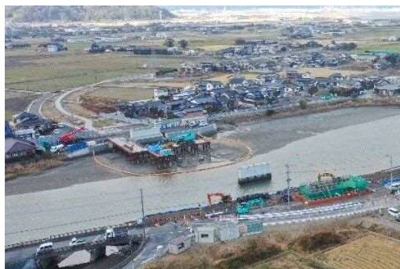
主要地方道 門司行橋線 行橋市工区 (行橋市)
