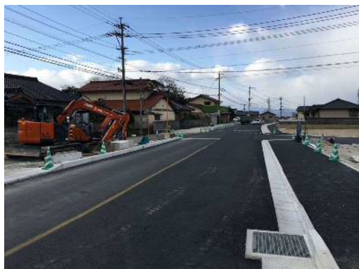
主要地方道 直方行橋線 道日木工区 (直方市)
