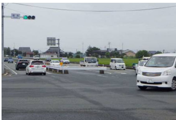
一般国道 442 号 大木大川バイパス（4車線化） (大木町～大川市)
