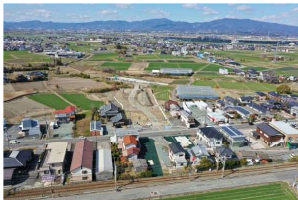
主要地方道 久留米柳川線 久留米市工区 (久留米市)
