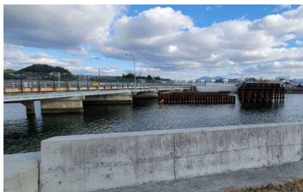
主要地方道 直方芦屋線 西祇園橋 (芦屋町)
