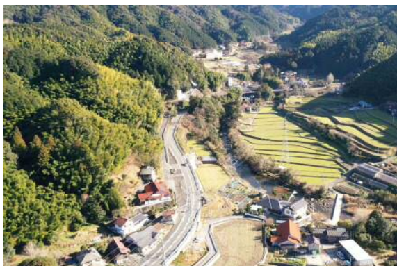
一般国道 385 号 南畑バイパス (那珂川市)
