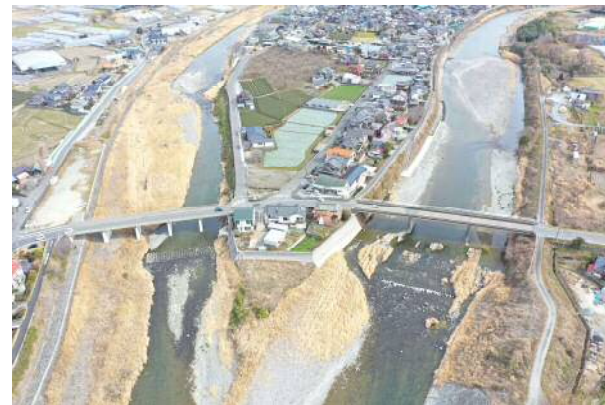
主要地方道 久留米立花線 柳島工区 (八女市)
