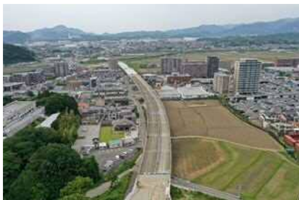
主要地方道 筑紫野古賀線 須恵・粕屋2工区 (須恵町～粕屋町)
