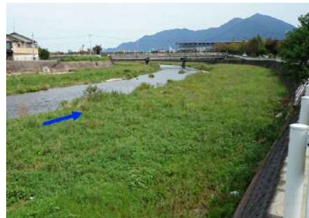
茶屋原堰（集水埋渠）平成27年9月の状況
