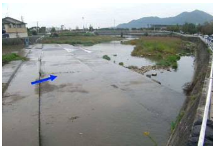
茶屋原堰（固定堰）平成23年11月の状況
