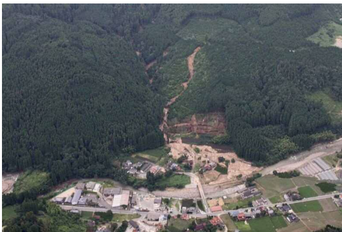
土石流の被害状況
