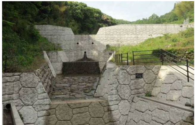
砂防堰堤 (山中川 八女市黒木町)
