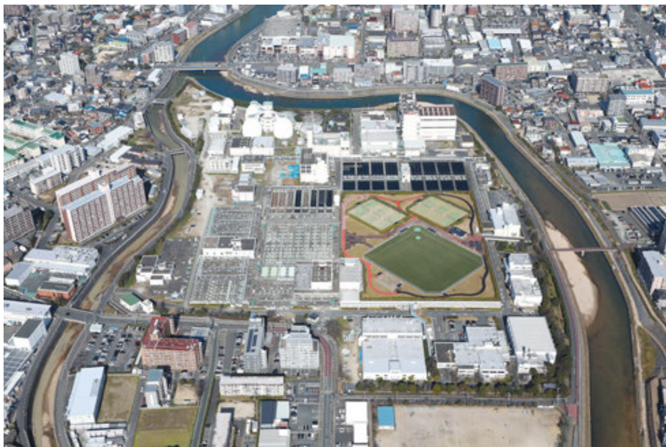
御笠川浄化センター
