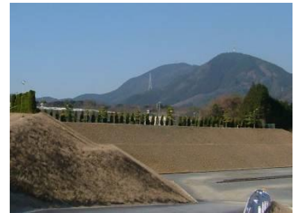
・芝生張りの法面と敷地周囲への植栽により修景に配慮した工場
