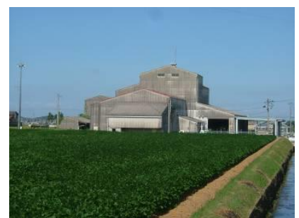
・勾配屋根とし、壁面を分節化して建築ボリュームを大きく見せない配慮（他都市事例）
