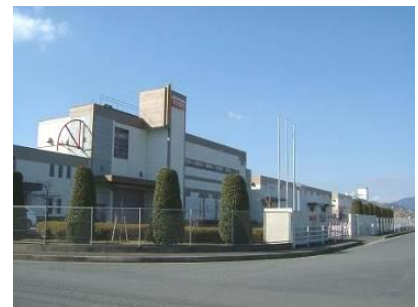
・建築物の高さに変化をつけたり、壁面に表情を持たせることにより、圧迫感を軽減する
