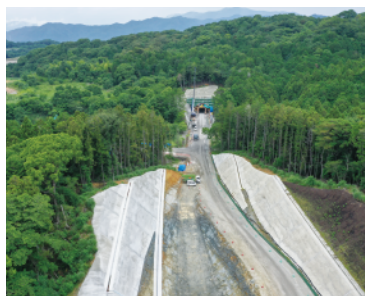
一般国道322号 嘉麻バイパス (嘉麻市)
