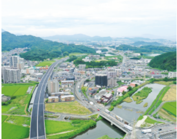
主要地方道 門司行橋線 (行橋市)
