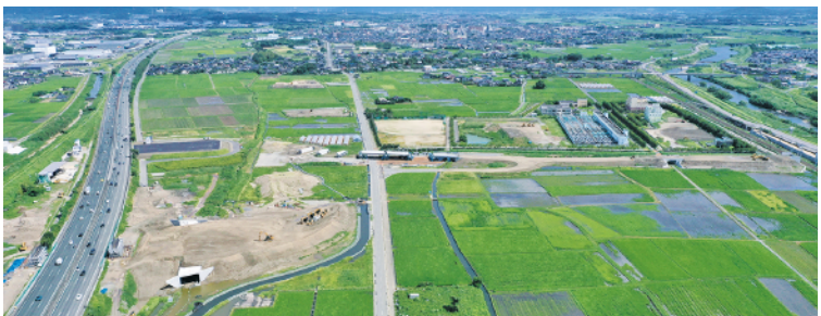
主要地方道 鳥栖朝倉線 (小郡市)
