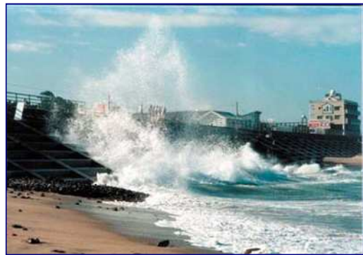
高波による越波(安岐海岸塩屋地区 大分県)
