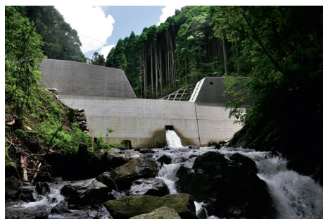
土砂の流出を防止する治山ダム
