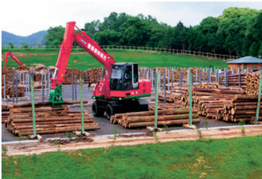
ストックポイントでの木材の集積状況
