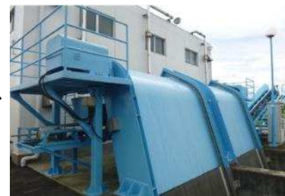
<対策後>除塵機補修
