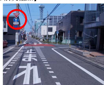
<対策後>一時停止標識の設置
