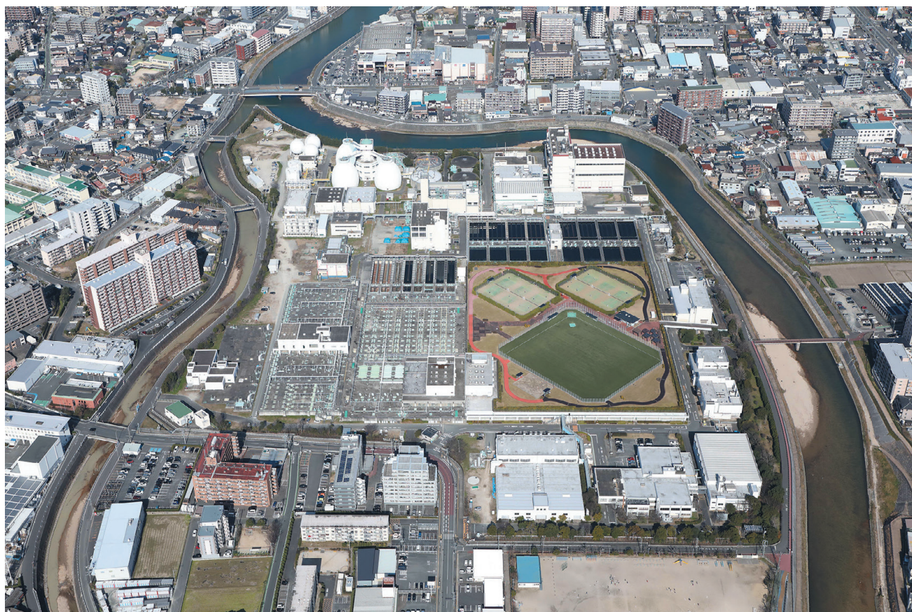
御笠川浄化センター
