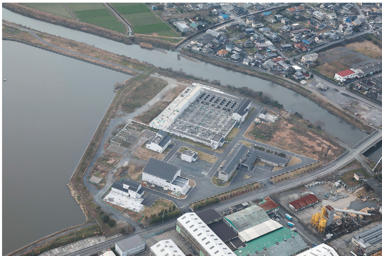
遠賀川下流浄化センター
