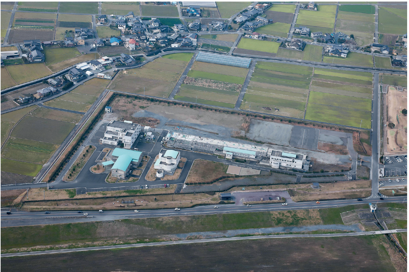
遠賀川中流浄化センター
