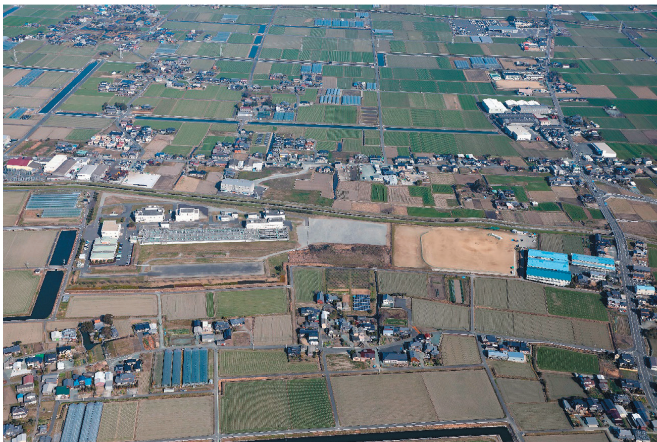
矢部川浄化センター
