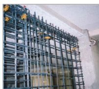
コンクリート壁の新設
