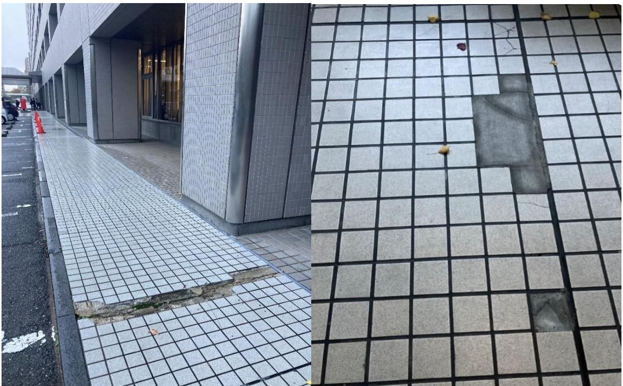
(監査人撮影:北棟九大病院側 102 会議室付近)
