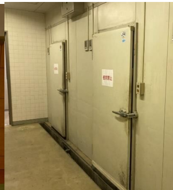
(監査人撮影:地下冷蔵施設跡)
