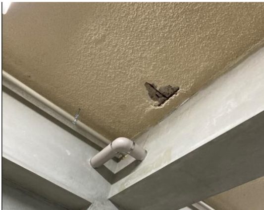
(監査人撮影:倉庫内の天井)
