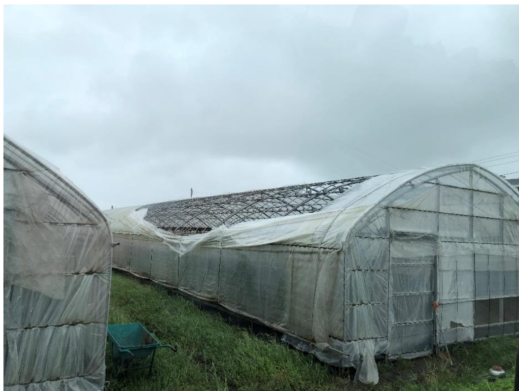
(6) 台風 11 号によるアスパラガス施設の被害
