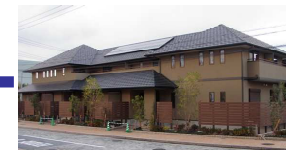
集合住宅等 1kW 燃料電池 8台
