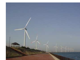
風力発電設備
