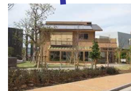
エコハウス 1kW 燃料電池 1台
