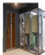
集合住宅向けエネファーム
