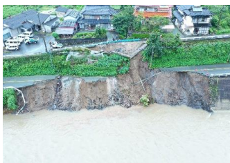
道路復旧状況 八女香春線(八女市)
