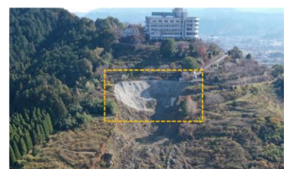
モルタル吹付施工(被害拡大防止の応急対策)
