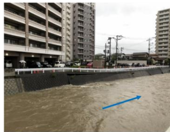
河川復旧状況 山口川(筑紫野市)
