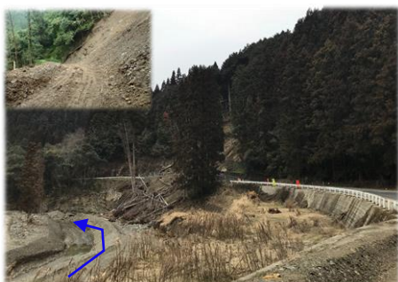
道路啓開状況
