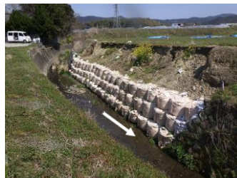
河川復旧状況 こうだらき 上津荒木川(久留米市)
