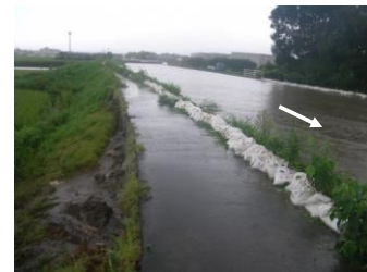
河川復旧状況 花宗川(筑後市)
