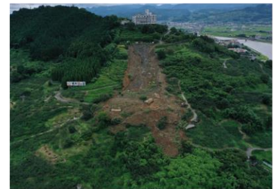
砂防復旧状況 高山市 高山地区(朝倉市)
