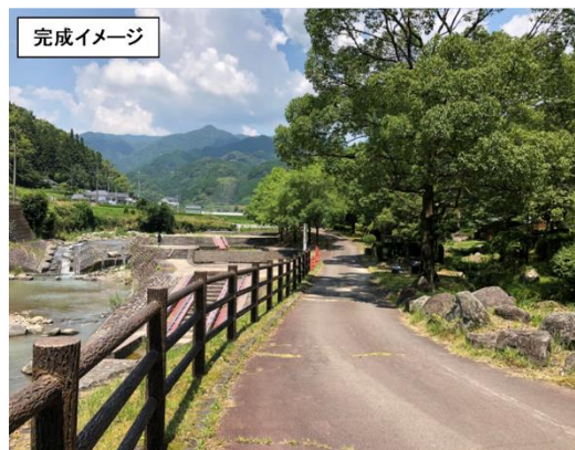
宝珠山川管理用通路の整備
