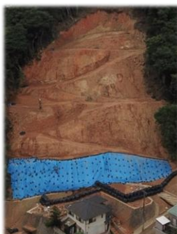
応急復旧状況
