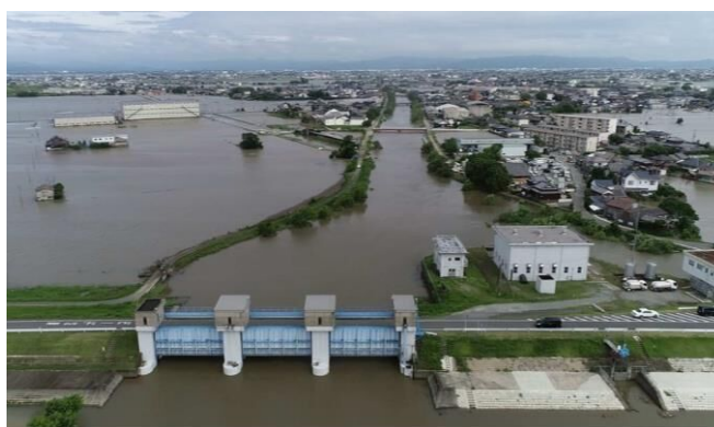
山ノ井川（久留米市） 平成30年7月豪雨による災害
