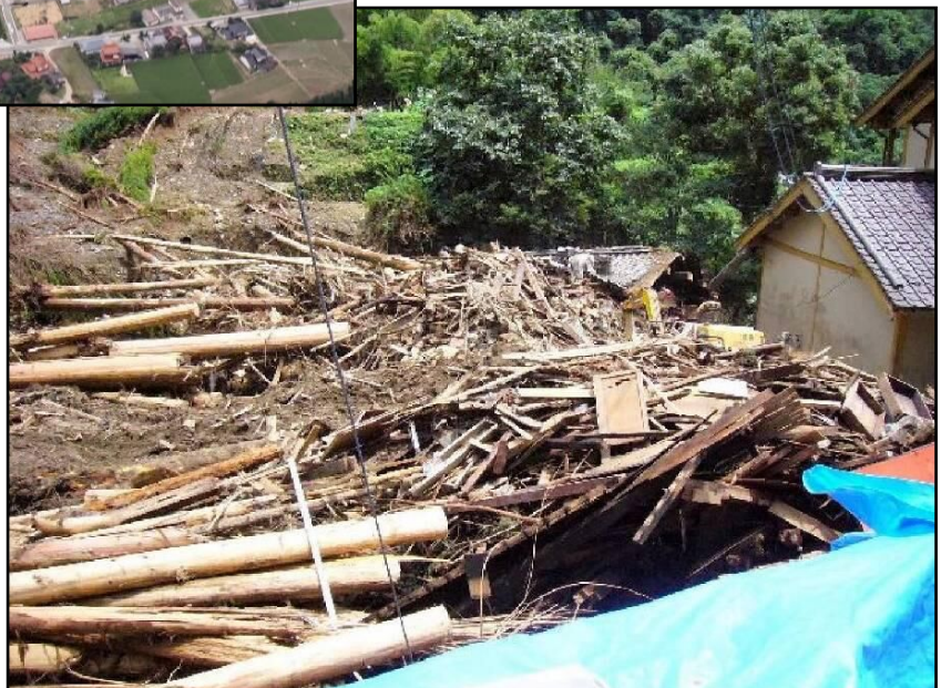
土石流の被害状況 (志屋川 八女市)
