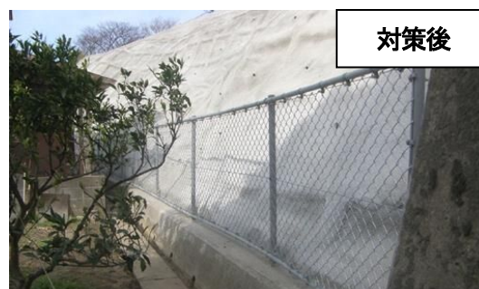
（急傾斜地崩壊対策）モルタル吹付工による改築
