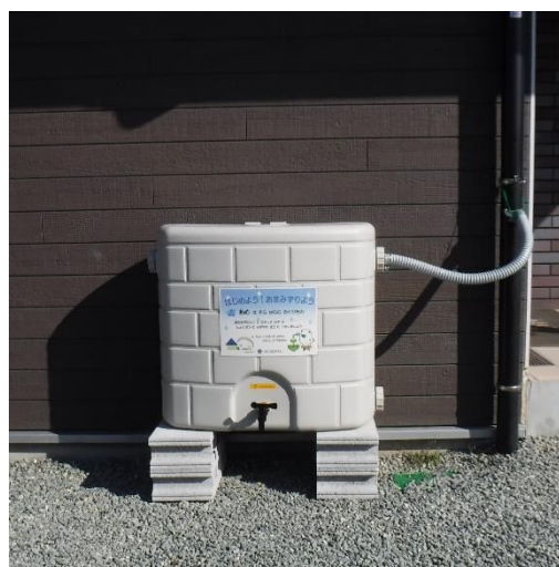
雨水タンクの設置状況
