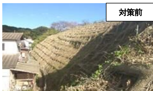
（急傾斜地崩壊対策）モルタル吹付工による改築
