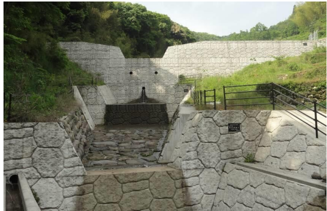
砂防堰堤（山中川 八女市黒木町）
