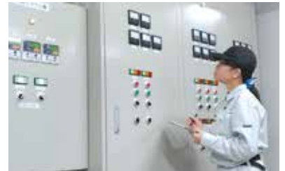
空調設備運転実習
