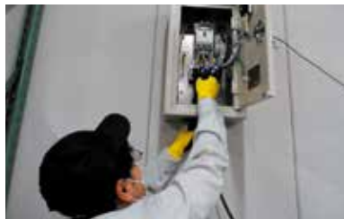
動力配線工事実習
