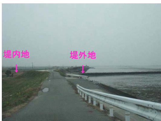
写真 5-1 有明海沿岸の堤防 堤内地と堤外地の地盤の標高差はほとんどない
