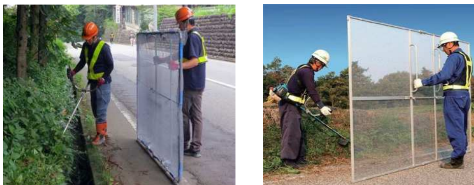
ネットによる作業例
