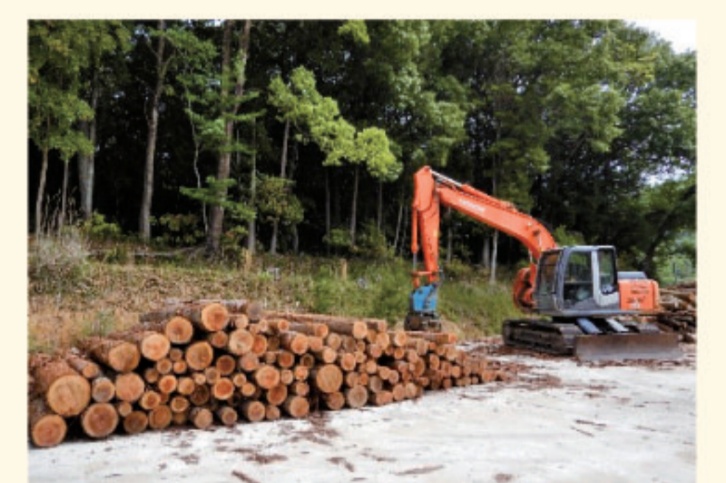
集出荷場(土場の舗装)
