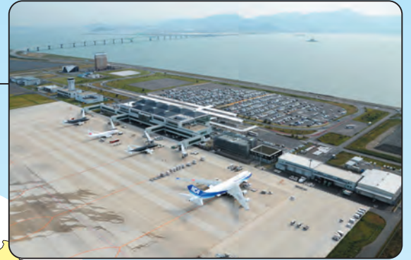
北九州空港（北九州市・苅田町） 工事費約1,024億円
