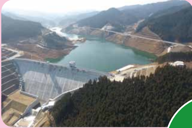
伊良原ダム（みやこ町）
