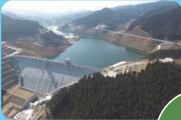
伊良原ダム（みやこ町）
