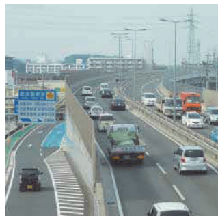
橋や道路の整備
